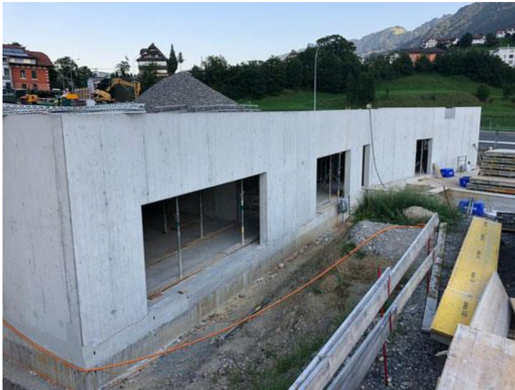
Bildlegende: Rohbau des Materialraumes in Oberarth
